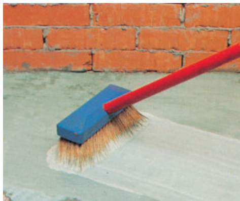
Εφαρμογή συγκολλητικού ασταριού ενισχυμένου με Planicrete
