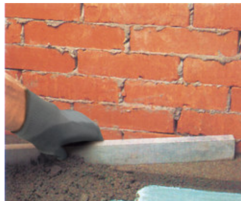
Εφαρμογή αγκυρούμενης τσιμεντοκονίας δαπέδου ενισχυμένης με Planicrete
